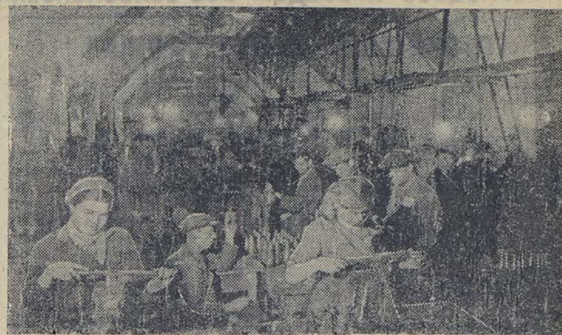
Севастополь в дни обороны. Предприятия Севастополя, переведенные глубоко под землю, ни на час не прекращают работу, выпуская вооружение для героических защитников города. На снимке: В одном из цехов Н-ского комбината.
